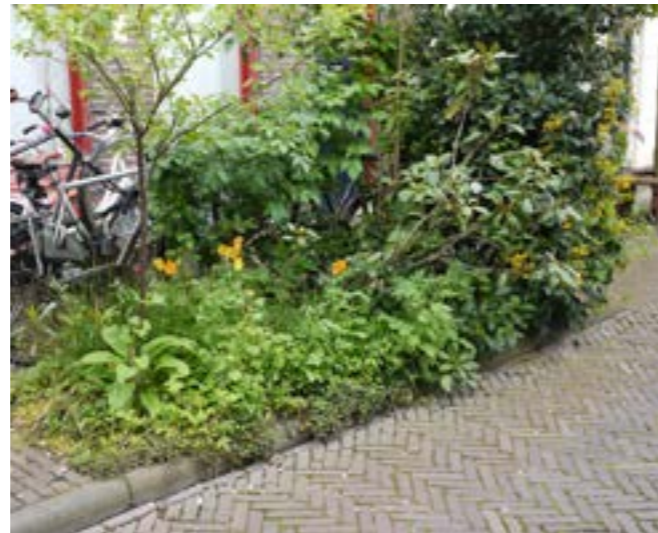
Standaardmateriaal bestrating: bijvoorbeeld klinkers
