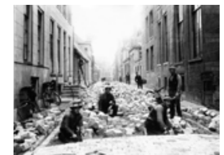
Historische bestrating: behoud of hergebruik
