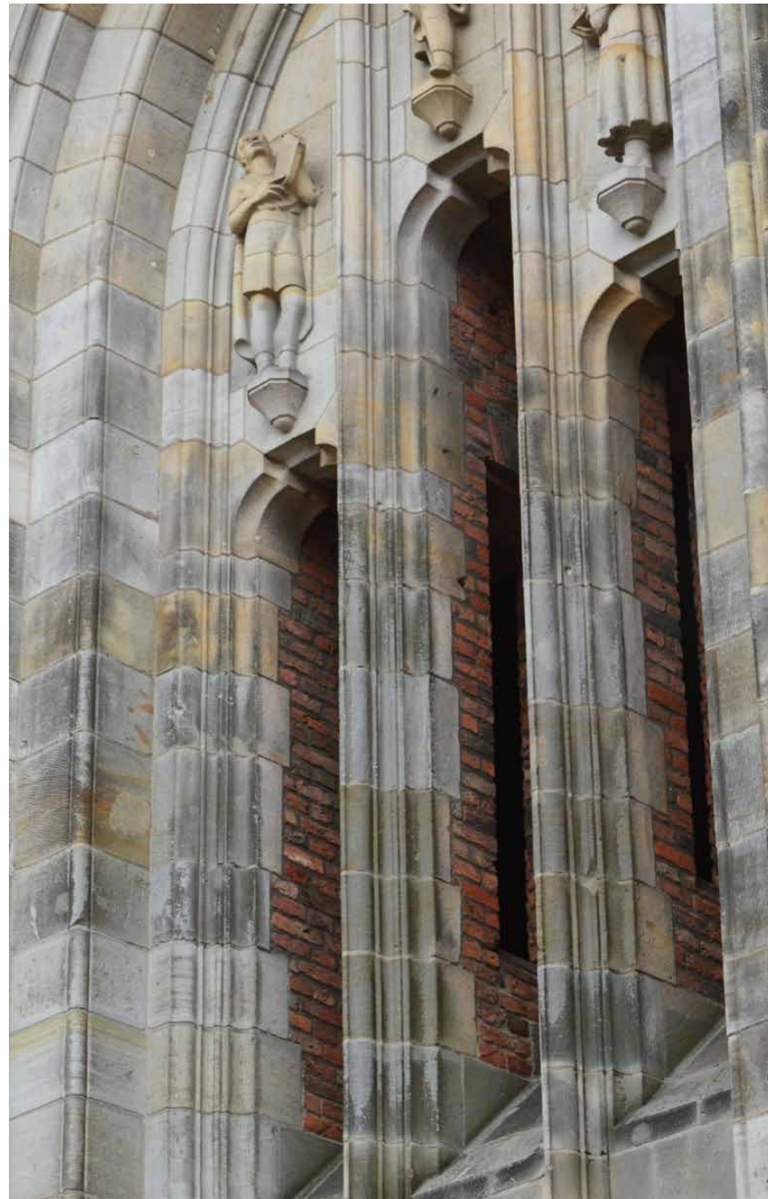
Martinitoren westzijde: Baksteen met verkleiding Natuursteen
