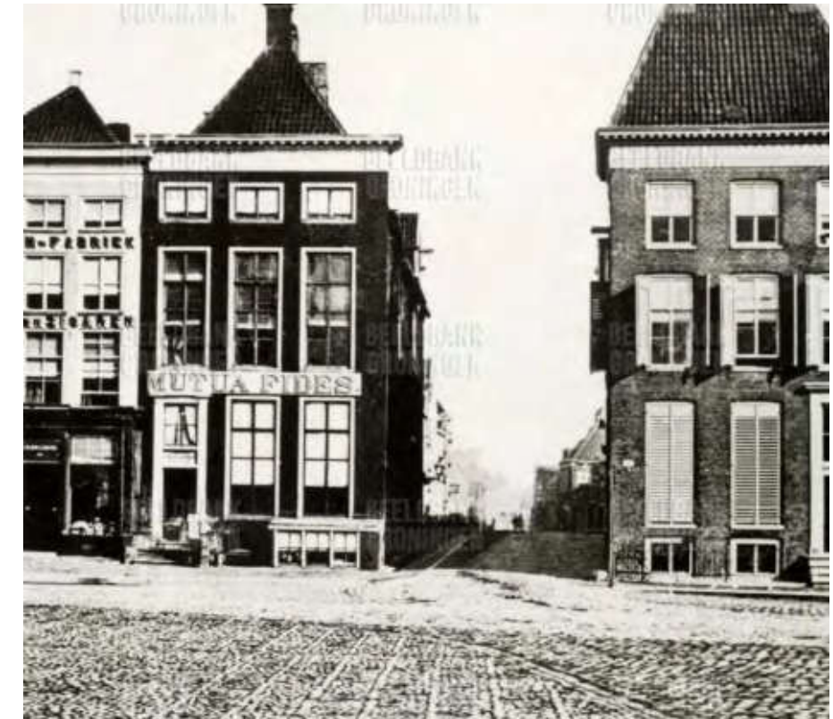
Noordzijde met ingang Oude Ebbingestraat . Op de voorgrond de met zwerfkeien bestrate markt en rechts een rijbaan, bestraat met keien (Quenast of lava-keien), een innovatie uit het midden van de 19e eeuw. Bron: Historische ontwikkeling van de openbare ruimte Grote Markt te Groningen
